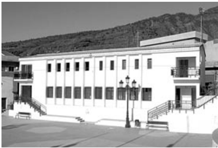
La edificación situada junto a la plaza de Iguete será sustituida por un inmueble que tendrá un uso más adecuado a la demanda./EL DÍA
